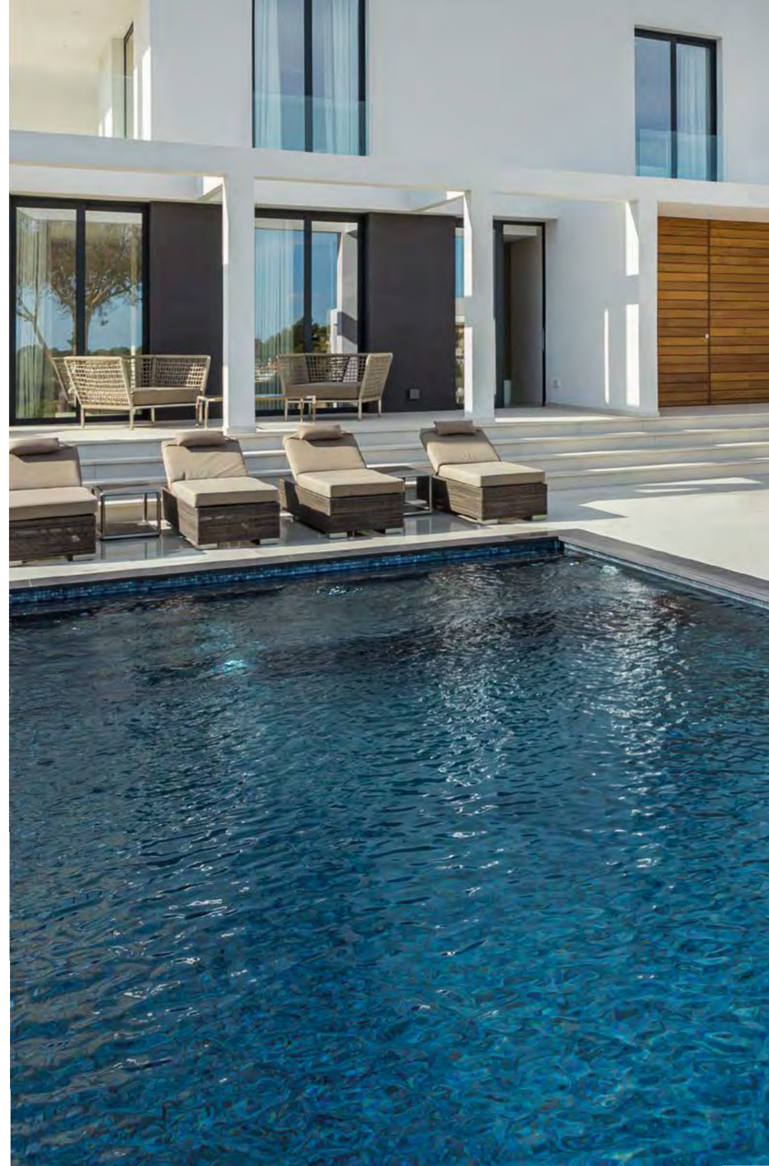
Residencial Costa den Blanes, Mark Walker Architects | Opalo Negro.
