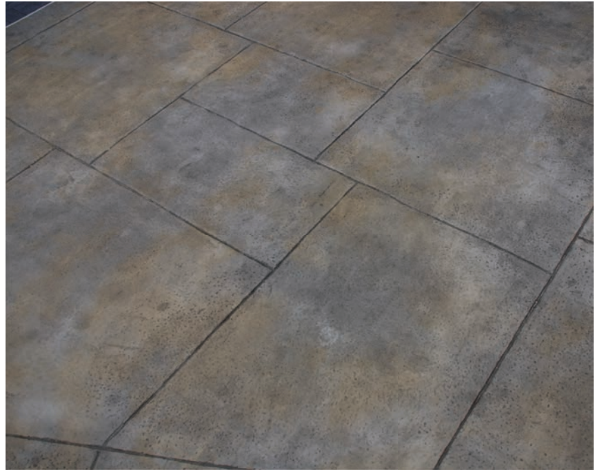
Lavado del pavimento. Pavimento terminado.. Washed pavement. Finished pavement.
