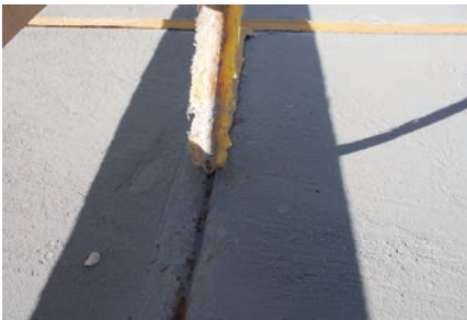
Retirado de plantillas de piedra antigua y lavado del pavimento. Removing piedra antigua straps and washing surface.
