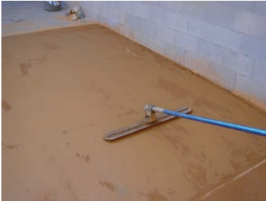
Base capa rodadura y pigmentación. Alisado de la capa de rodadura. Espolvoreo de desmoldeante. Hard and pigment. Troweling hard. Application of release powder.
