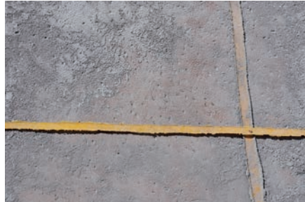
Distribución e introducción de las planillas de piedra antigua. Placing straps.
